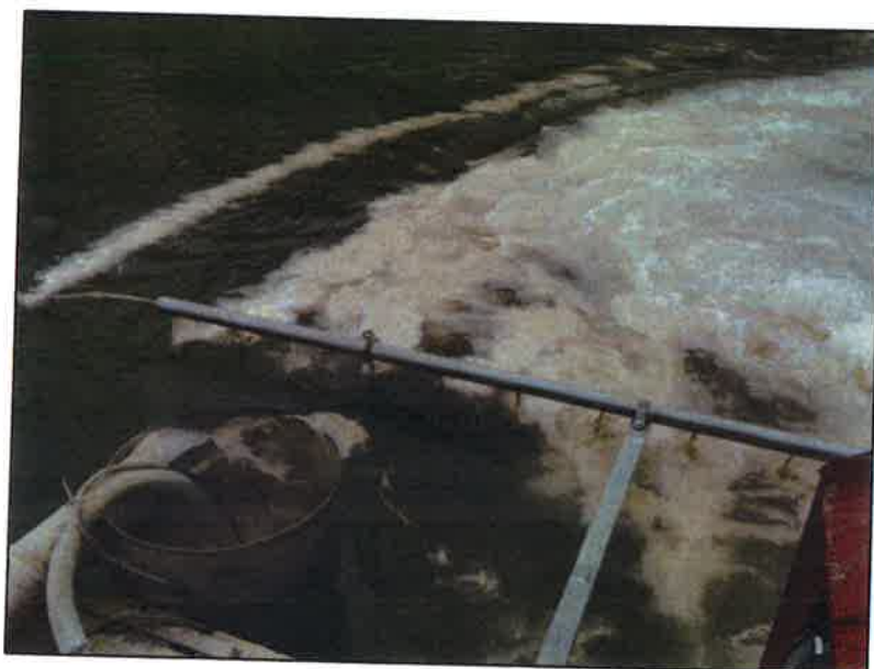
Fot. 6. Zbliżenie na lance rozprowadzającą z widocznym kolorem mieszaniny wody i gliny bentonitowej na powierzchni, sedimentacja preparatu trwa bardzo szybko nie pozostawiając na powierzchni wody zanieczyszczeń
