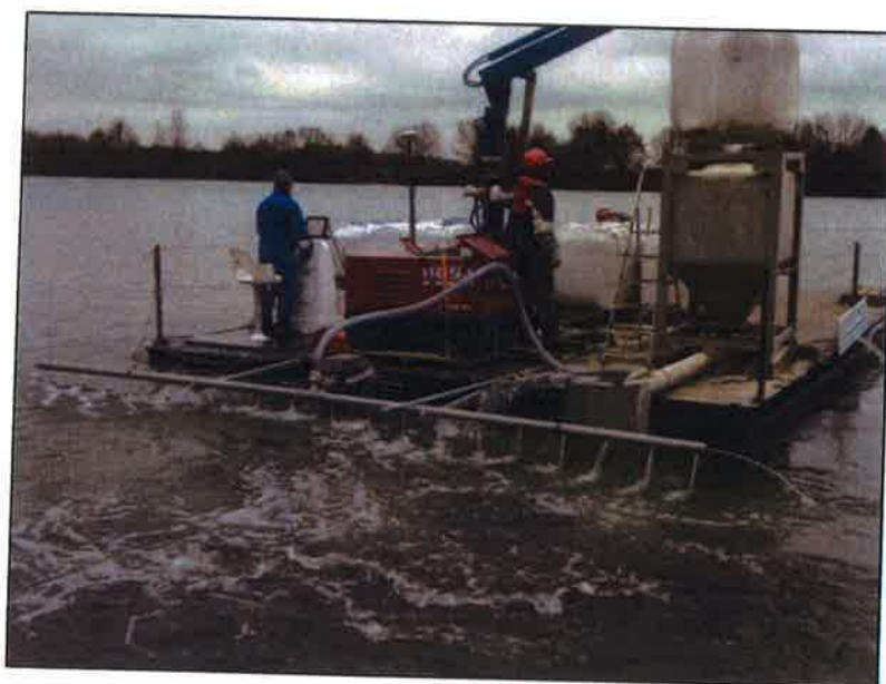
Fot. 5. Barka z kilkoma „Big Bagami” preparatu w czasie pracy, widać lance rozprowadzającą preparat
