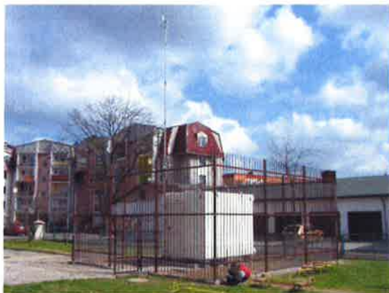
Fot. 1. Stacja pomiarowa
