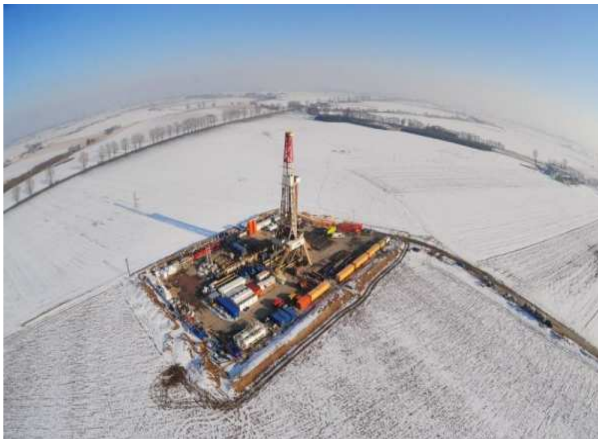
Fig. 3 Wiertnia z zamontowanym urządzeniem wiertniczym typu IRI E-1200 (fot. Nafta Piła )
