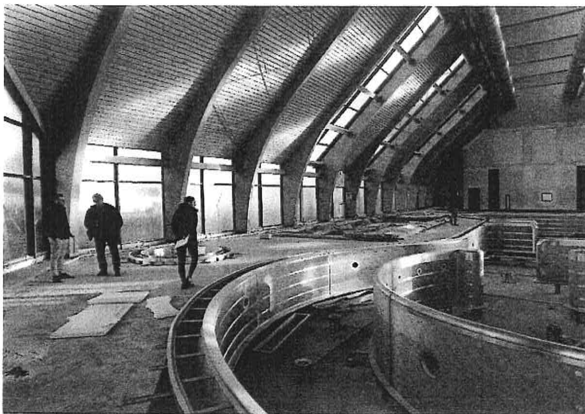
Fot.9. Część basenowa
