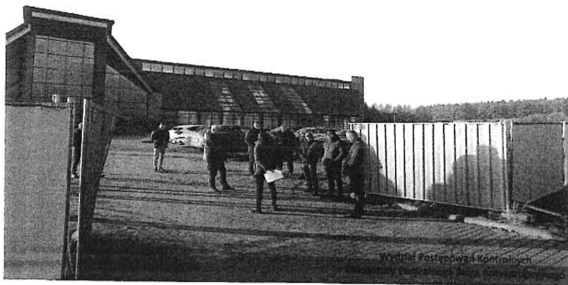
Fot. 2. Wjazd na budowę
