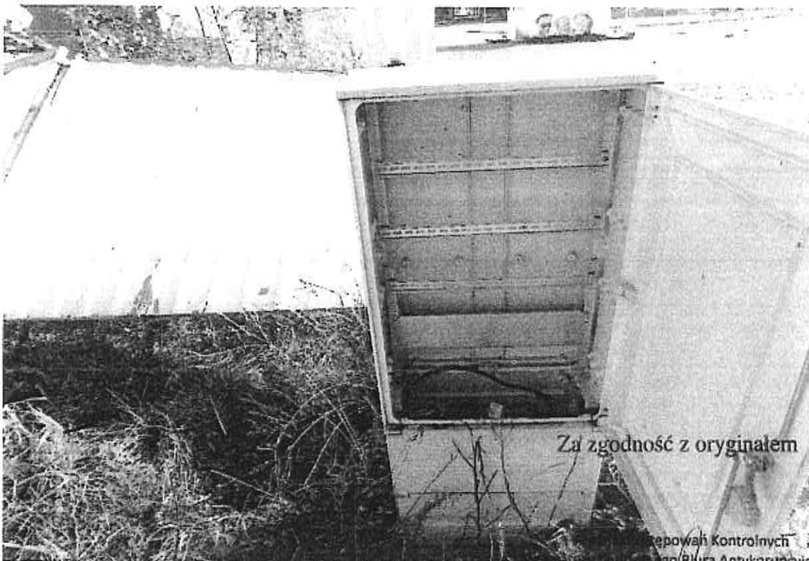
Fot.66. Skrzynka elektryczna nie uzbrojona
