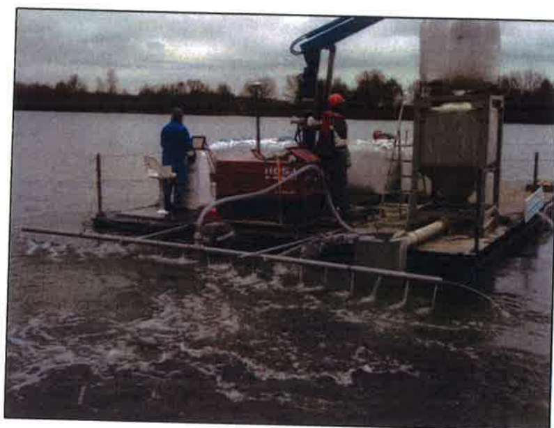
Fot. 5. Barka z kilkoma „Big Bagami” preparatu w czasie pracy, widać lance rozprowadzającą preparat
