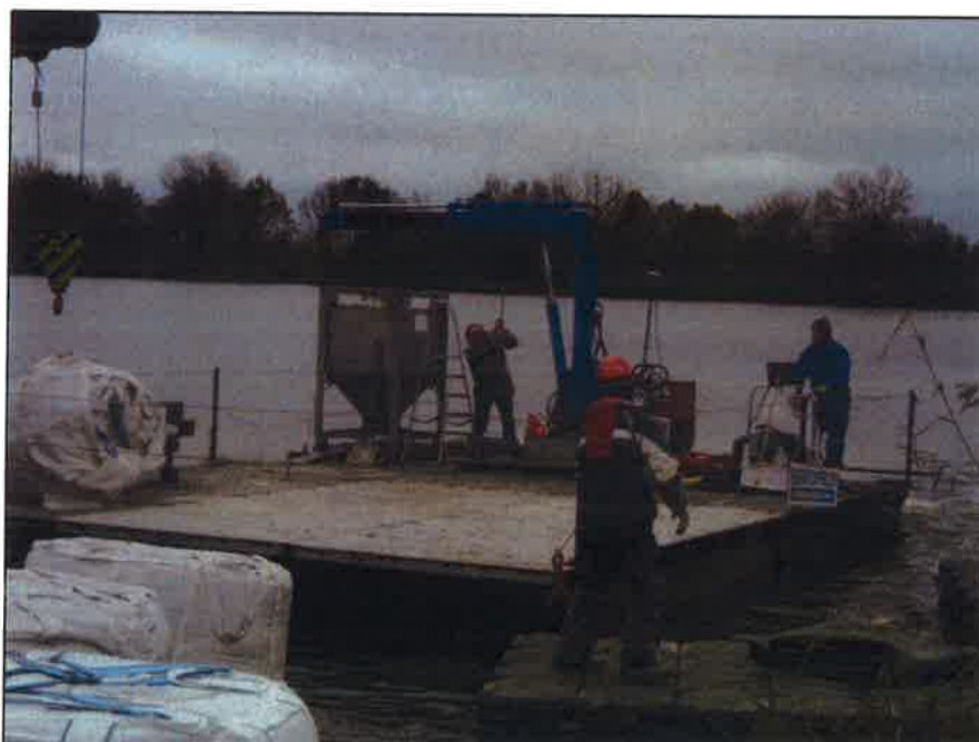
Fot. 2. Barka transportowa przy pontonowym pomoście wykonanym dla potrzeb aplikacji
