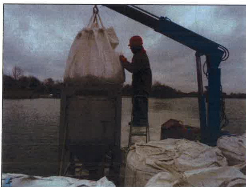
Fot. 4. Załadunek preparatu do mieszalnika na barce transportowej
