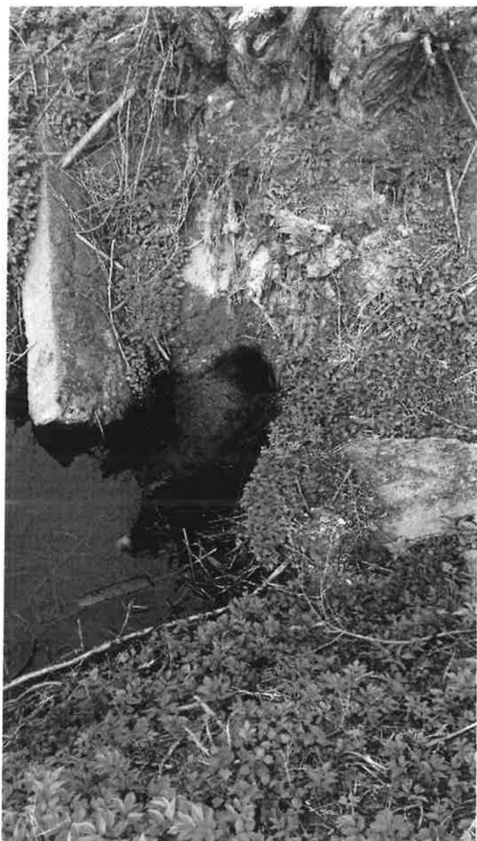
Zdjęcia: stan istniejący omawianego przepustu
