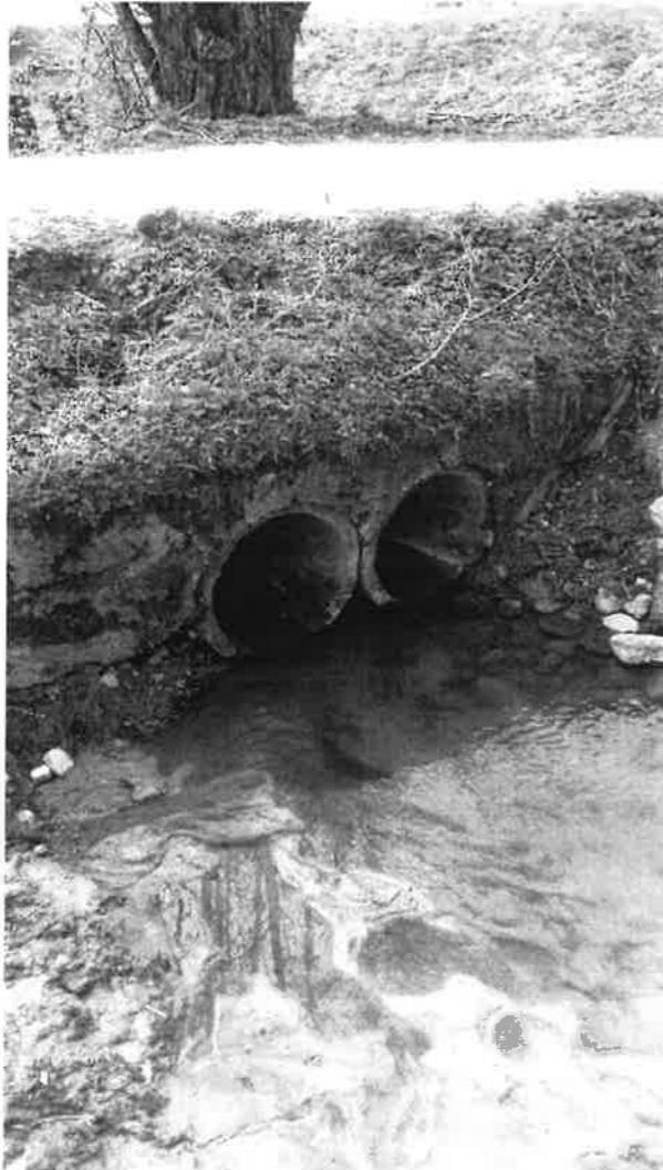
Fot.: stan istniejący omawianego przepustu
