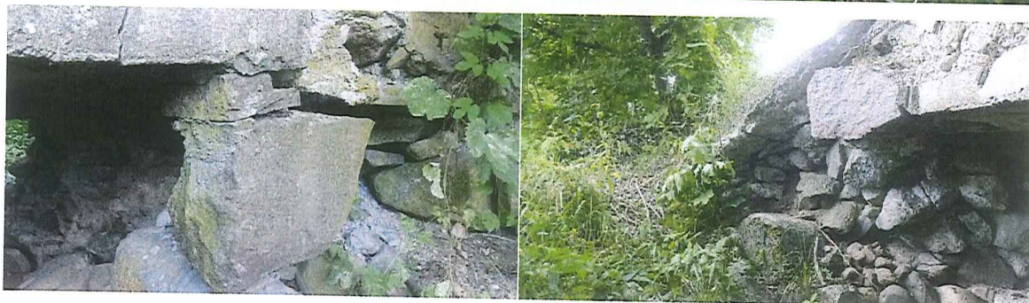
fot. 3-5. Widok od strony górnej wody
