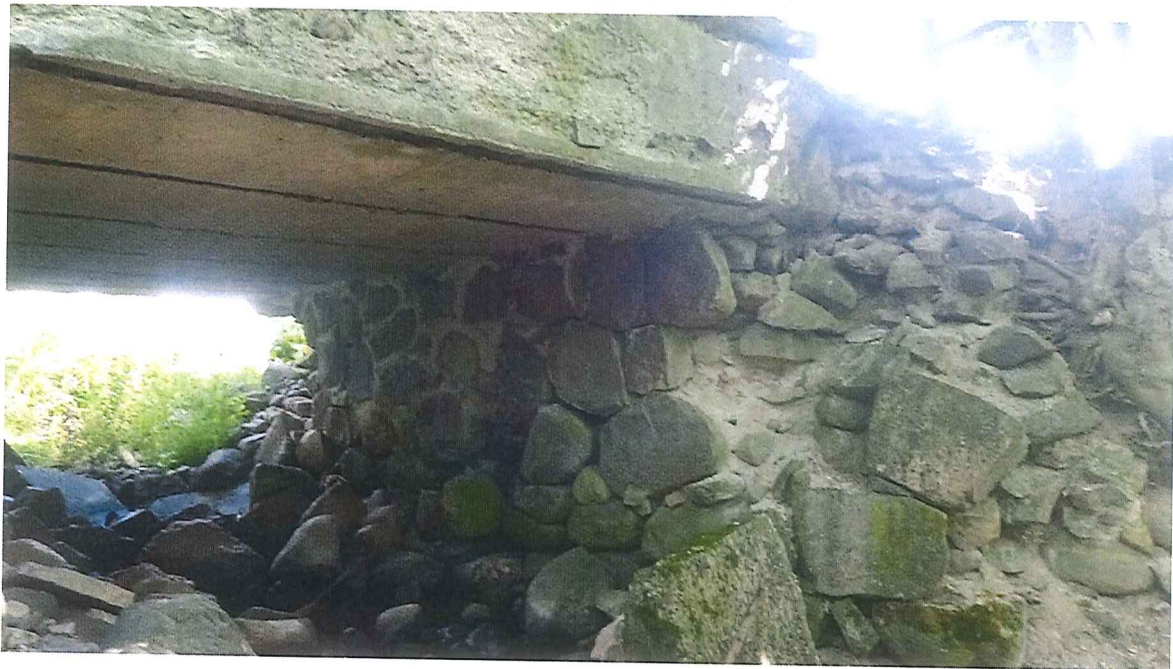
fot. 10. Widok podpory południowej
