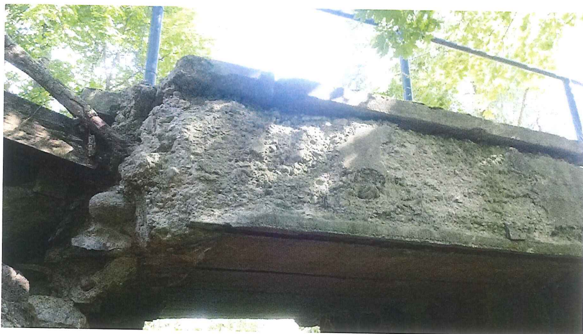
fot. 11. Konstrukcji nośnej
