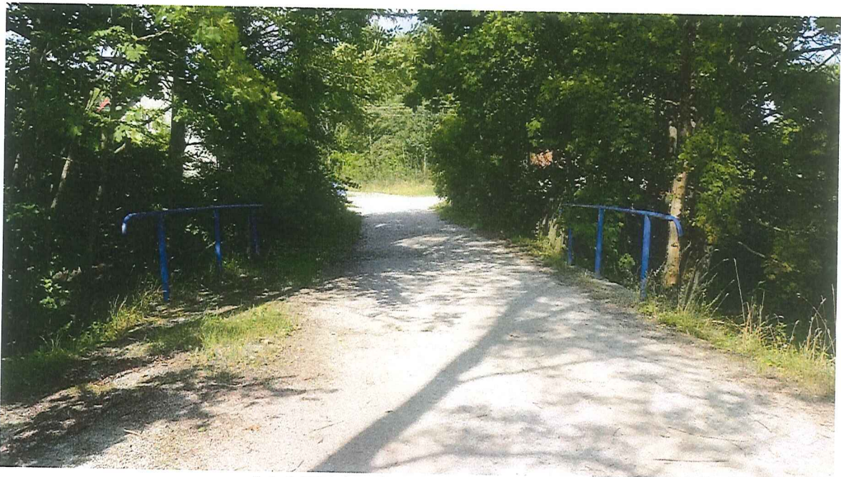
fot. 1. Widok ogólny (z powierzchni jezdni)
