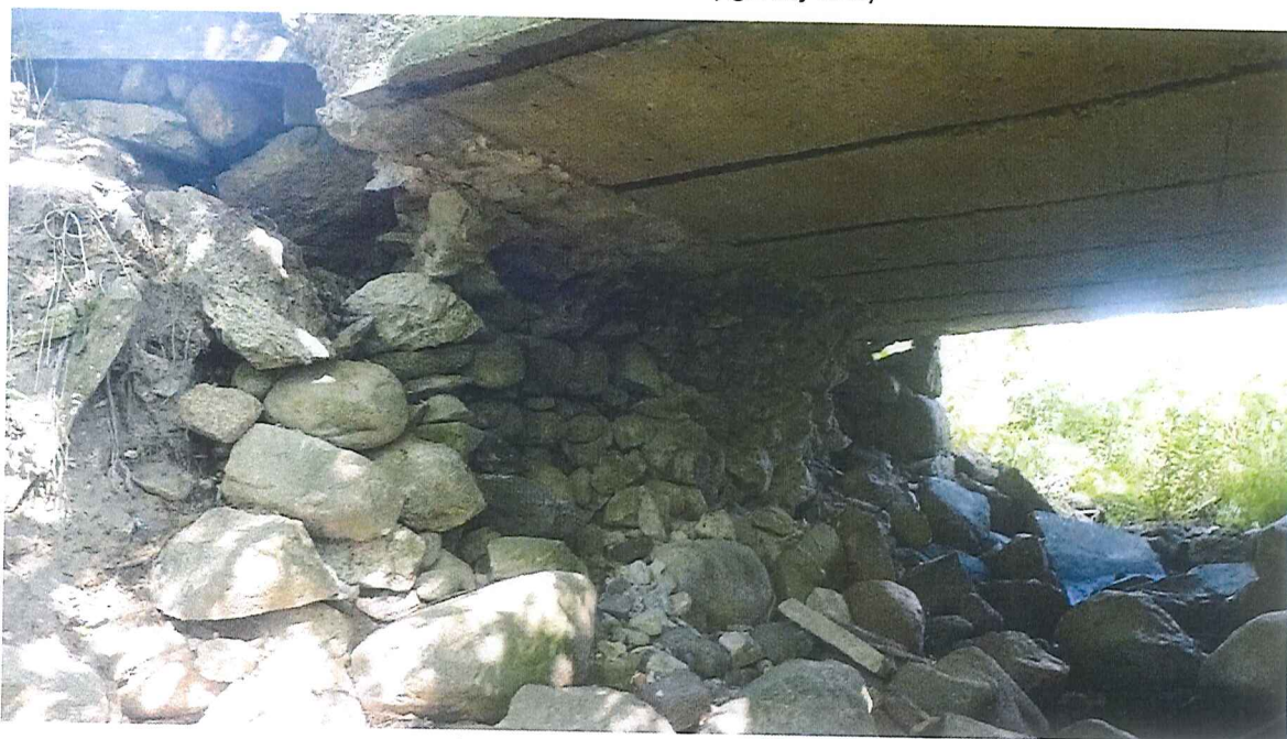
fot. 6. Widok podpory północnej
