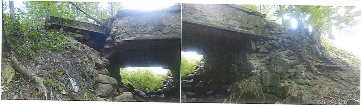
fot. 7-9. Widok od strony dolnej wody
