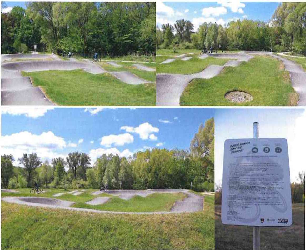
Rys. 4.1. „Budowa rowerowego placu zabawy typu pumptrack”.
