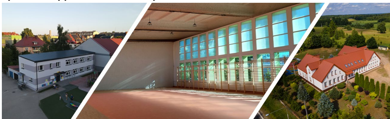
Rys. 1.7. Szkoły po termomodernizacji.
