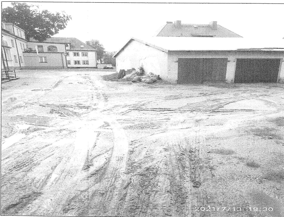
Fotografie obrazujące obecny stan drogi.
